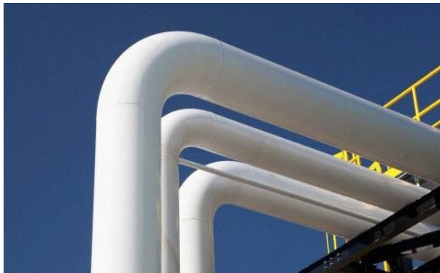
Fig 8.9 Aplicarea sistemului ThermoSave pe conducte - Anglia 2
