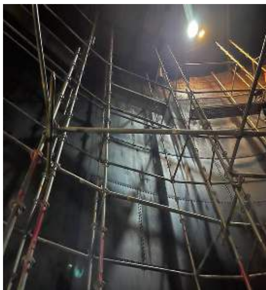
Fig 6.17 Interior rezervor studiu de caz 2
