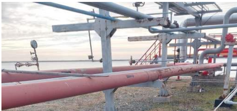
Fig 5.8 stare tehnică precară a conductelor (sursă autor)
