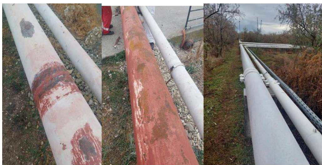
Fig 6.19-6.21 Conducte Inainte de reabilitare și după
