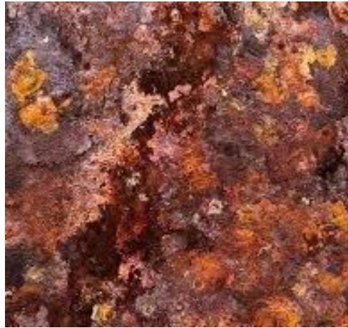
Fig 6.12 Detaliu rezervor la interior
