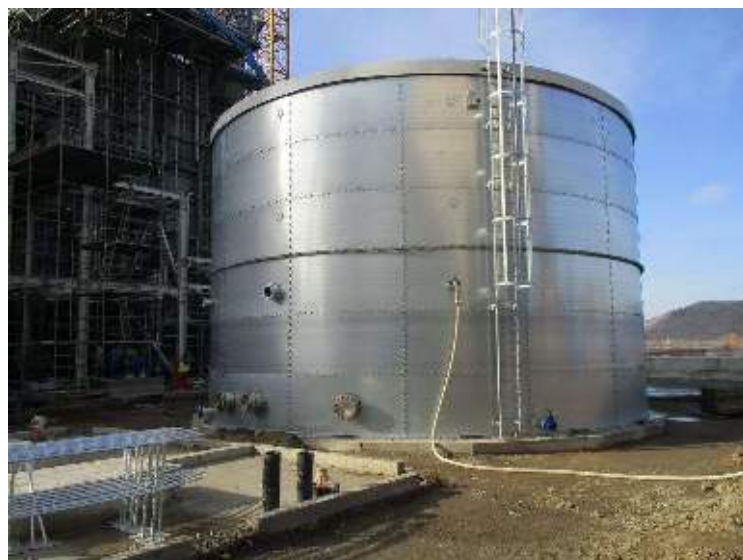
Fig 6.10 Construcțiile din metal sunt supuse degradării prin coroziune.
