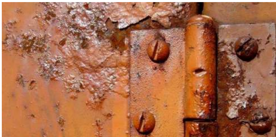
Fig 6.2 detaliu coroziune
