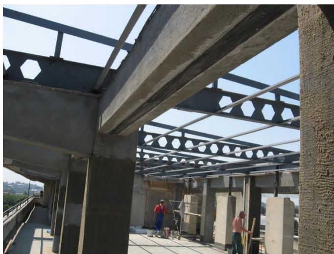
Fig. 4.4 Reparații finale cu sisteme compozite la elementele deteriorate (foto arhiva personală - Univ. Maritima din Constanta)
