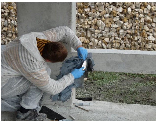
Fig. 4.10 Consolidare zona 2 cu ancore compozite
