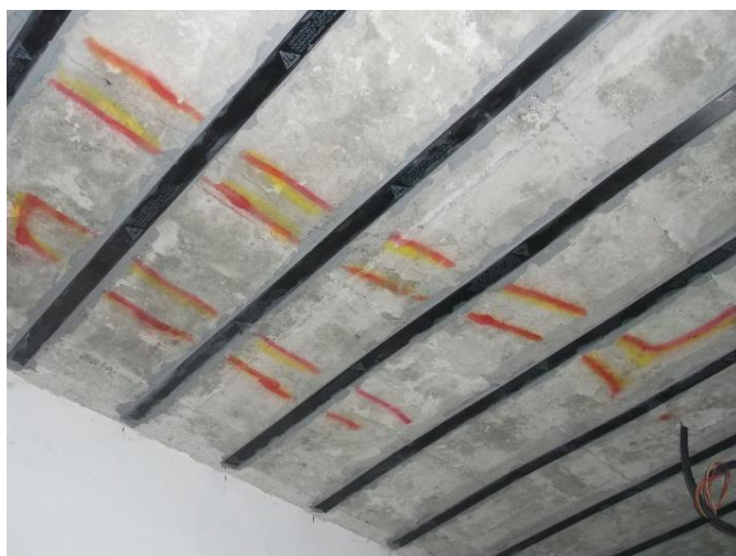
Fig. 4.5 Consolidare planșeu cu platbande compozite (foto arhiva personală - Univ. Maritimă din Constanța – imobil Baza Nautică)
