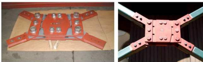
Figura 3.1.2 „Amortizor cu frecare de tip Pall
