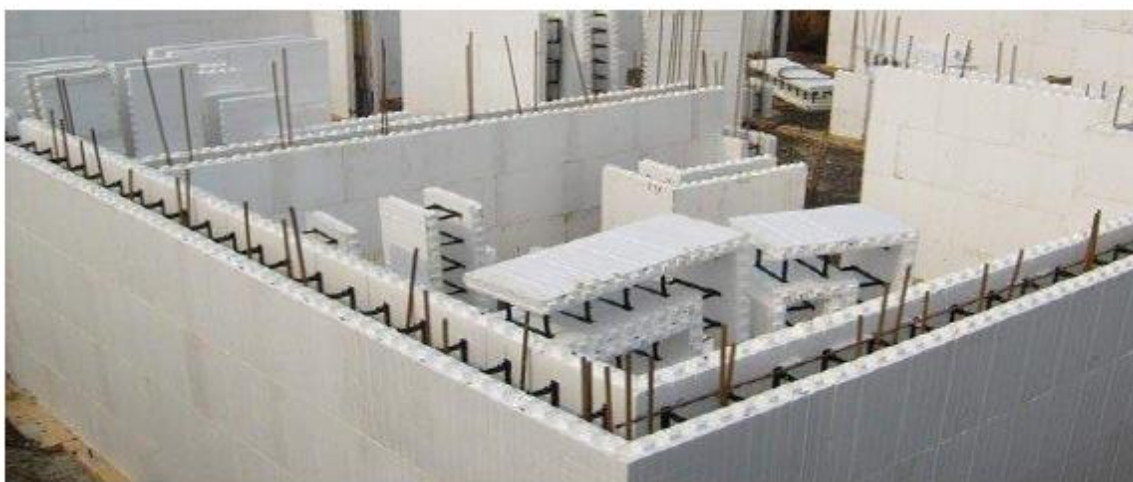
Imaginea (7) ICF cofraj din beton termoizolant (sursa: pmrpressrelease.com)
