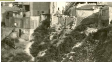
Imagini cu prabusiri ale unor constructii afereinte imobilelor situate pe str. A. Karatzali nr. 14 si 12, in urma surparii falezei. Sunt surprinse lucrari de sprijin a curtii imobilului de la nr. 8 -10
