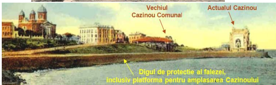
Figura 3.18 – Faleza amenajata cu digul si noul Cazinou (dupa foto arhiva Primaria Constanta)
