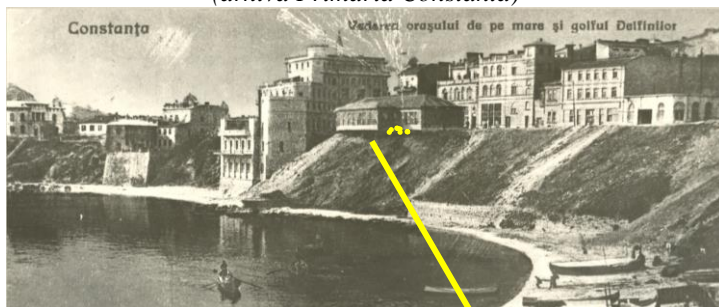
Figura 4.10 -- Faleza din dreptul Pieteii Ovidiu, unde era edificata o casa vecina cu Banca Nationala, ce ulterior s-a prabusit datorita instabilitatii falezei (arhiva Primaria Constanta)
