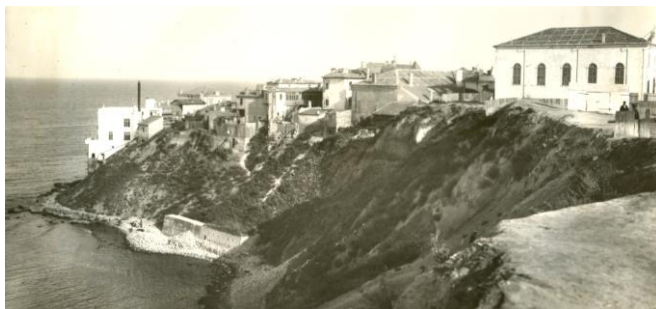
Figura 5.5 - Fotografie din anii 1915-1920 In primul plan, faleza de nord a str.Karatzali, cu urme evidente de surpare si afectare a fondului construit (arhiva Primariei Constanta)
