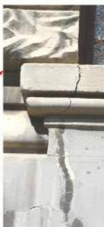
Figura 3.19 - Muzeul de Istorie Nationala si Arheologie – Constanta - detaliu fatada cu fisuri evidente – foto 2008 –
