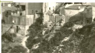
Imagini cu prabusiri ale unor constructii afacerite imobilelor situate pe str. A.Karatzali nr.14 si 12, in urma surparii falezei. Sunt surprinse lucrari de sprijin a curtii imobilului de la nr. 8 -10
