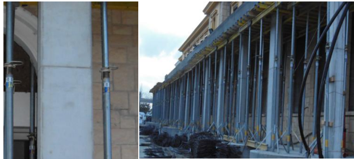
Fig.2.24,25-Elemente de construcție realizate din beton autocompactant(foto autor).
