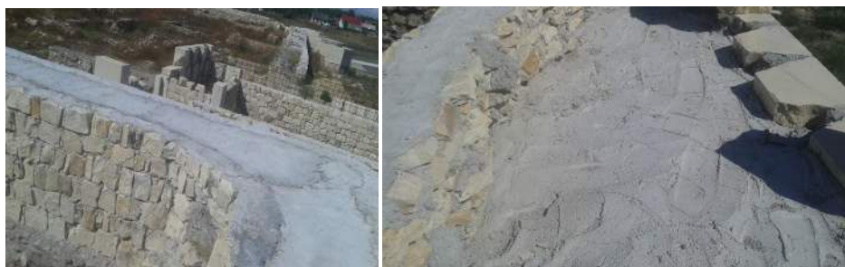
Fig.5.35,36- Restaurarea zidurilor Cetății Capidava utilizând beton convențional(foto autor)
