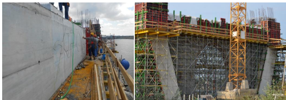
Fig.1.17,1.18,-Podul Canal Dunăre-Marea Neagră Km 0+540
