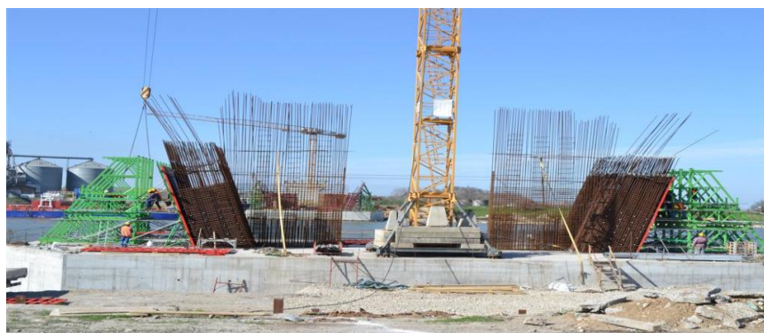
Fig.4.39- Elemente înainte de turnare în cadrul proiectului “Construcție pod peste canalul Dunăre-Marea Neagră, km 0+540”(foto autor)
