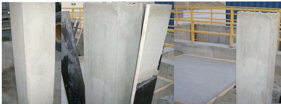
Fig.4.30,4.31,4.32- Elemente prefabricate din beton autocompactant după decofrare(foto autor)
