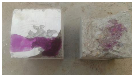
Fig.4.26- Evidențierea fenomenului de carbonatare prin tratarea betonului în spărtură cu fenoftaleină
