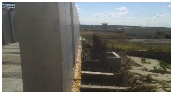
Fig.5.37-Element de construcție la Cetatea Capidava realizat din beton autocompactant.(foto autor)
