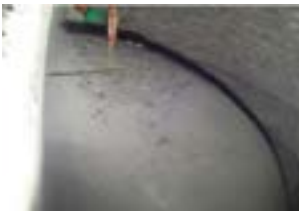
Fig. 3.50 - Colmatarea fisurilor cu rășini sau spume – (foto autor)
