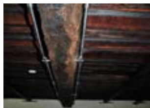
Fig. 3.28 - Consolidarea planșeului de lemn cu platbande și tiranți metalici. - (foto -João Appleton)
