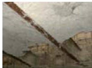
Fig. 3.38 – Bolțișoare prăbușite parțial – (foto autor)
