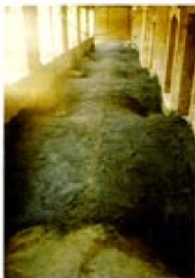
Fig. 4.5 - Cămășuirea unei bolți din zidărie cu plasă polimerică – (foto -João Appleton)
