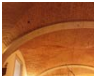
Fig. 2.8 - Planșeu din cărămidă – boltă tip Vela - (foto autor)
