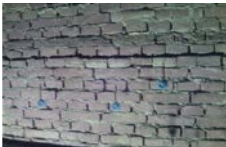
Fig. 5.48 - Determinarea absorbției apei cu presiune scăzută în situ – (foto autor)
