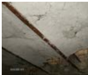
Fig. 3.62 - Investigarea planșeelor boltite de peste subsol – (foto autor)
