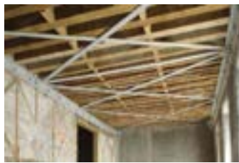
Fig. 3.24 - Consolidarea îmbinărilor dintre grinzi de lemn ale planșeului și zidurile pe care descarcă - (foto -João Appleton)
