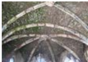
Fig. 2.8 - Planșeu din cărămidă – boltă tip Vela - (foto autor)
