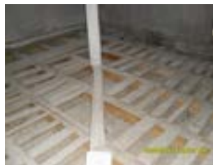
Fig. 3.89 - Investigarea și diagnosticarea planșeului peste parter – (foto autor)
