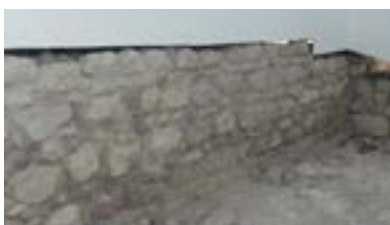
Fig. 2.107. Conservarea unui zid de piatră – castelul São George din Lisabona (Portugalia) - Protejarea structurilor din piatră în muzee
