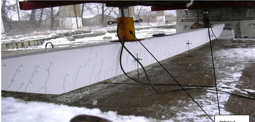
Fig. 3.20.-Pana de beton armat încercată
